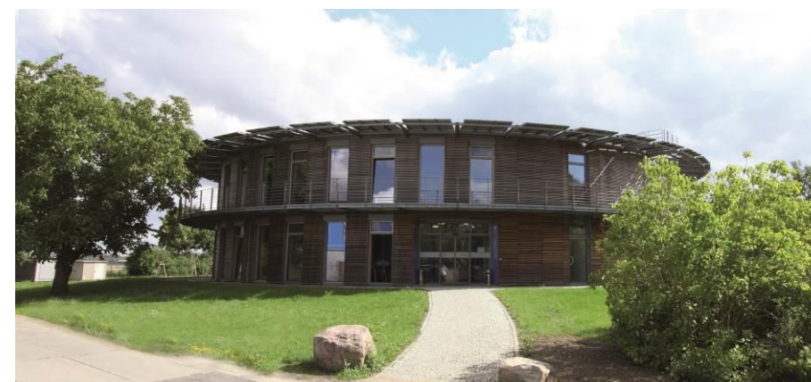
Photographie 1. Centre de Conduite d'ENERTRAG
