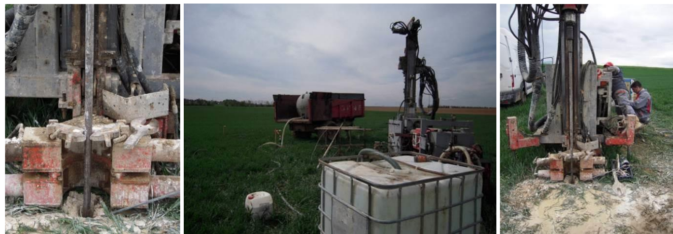
Photographie 2. Campagne de reconnaissance géotechnique
