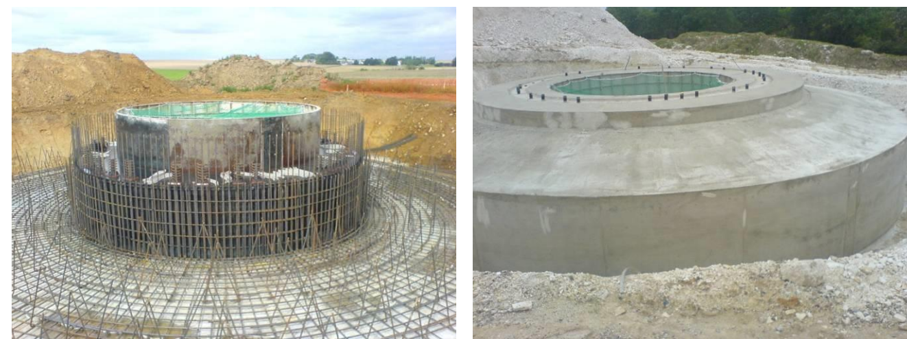
Photographie 3. Fondations d'une éolienne
