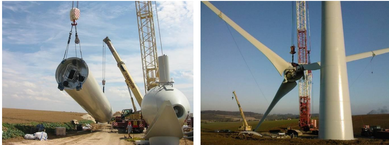
Photographie 6. Assemblage d'une éolienne (Source : Enertrag)
