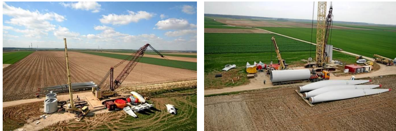
Photographie 5. Aires de levage (Source : Enertrag)
